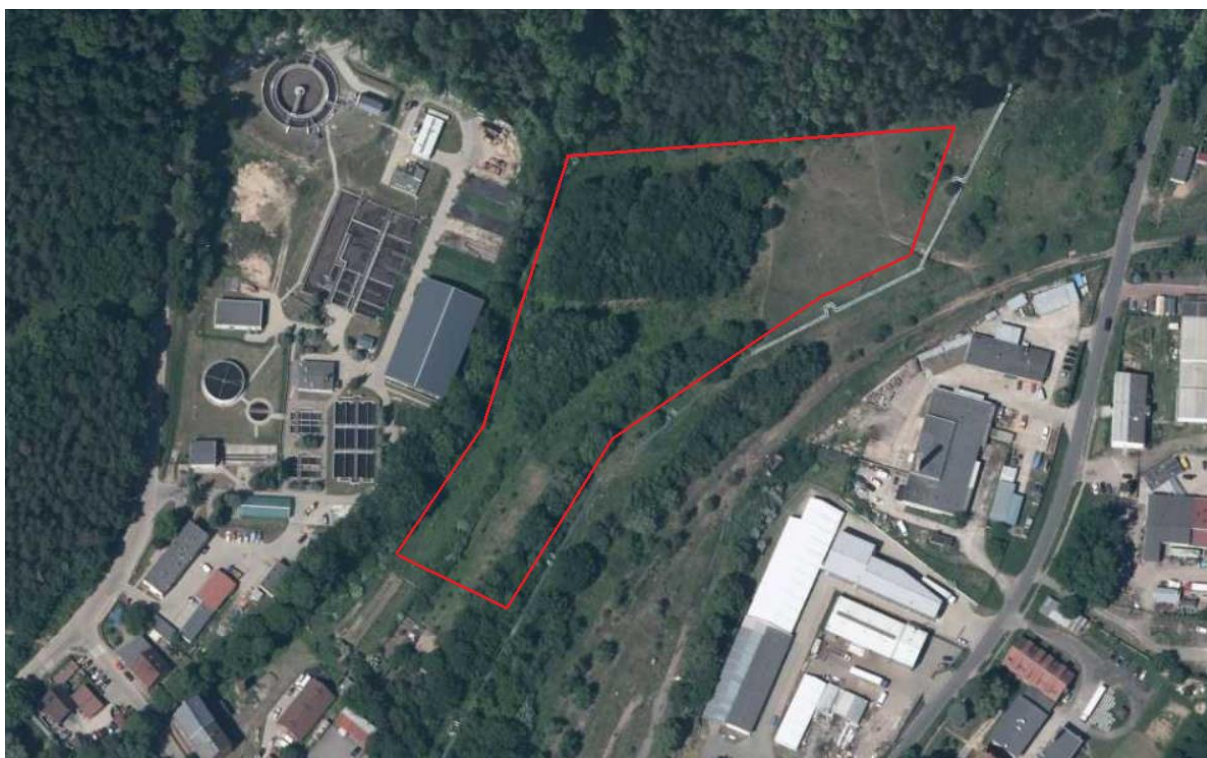
Rys. 3.1. Miejsce przeznaczone pod zabudowę instalacji fotowoltaicznej
