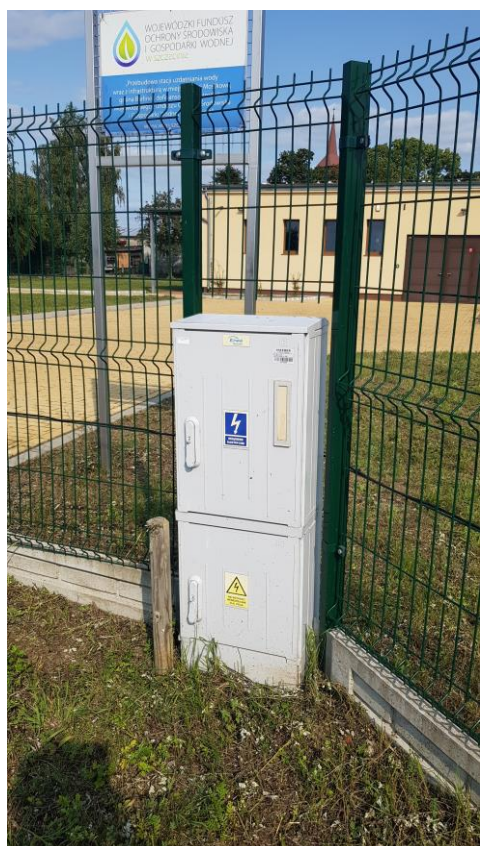
Rys. 2.8. Miejsce przyłączenia SUW Mostkowo do sieci elektroenergetycznej
