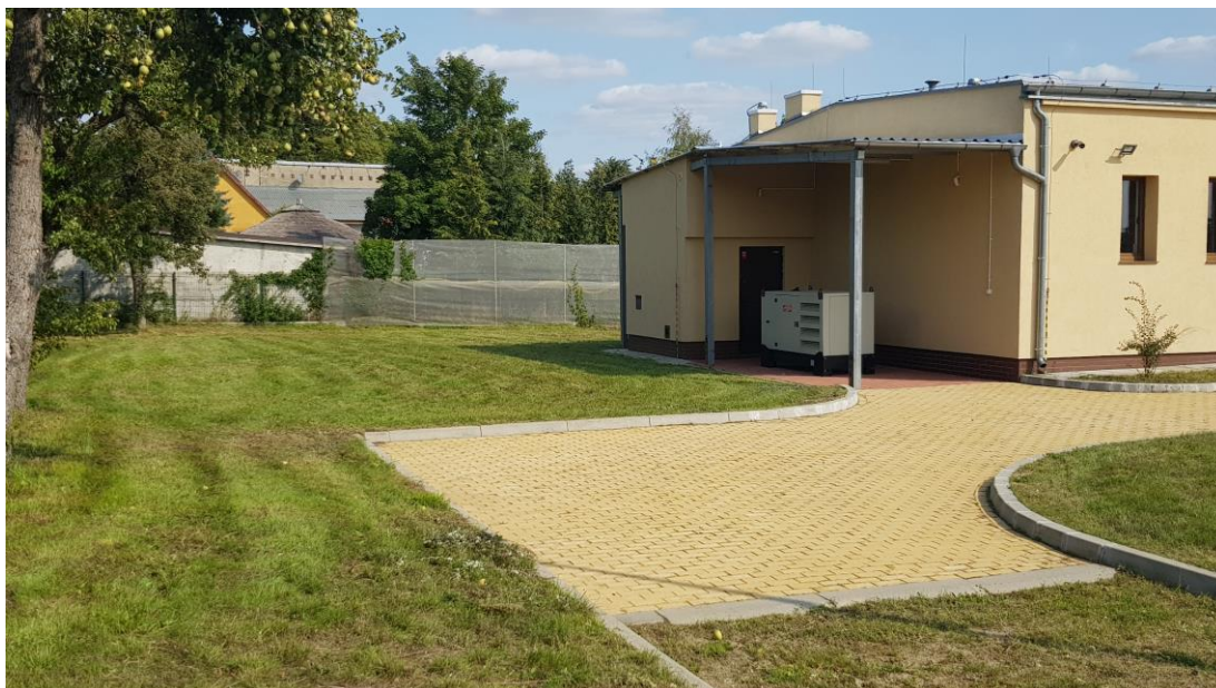
Rys. 2.5. Miejsce przewidziane pod budowę instalacji fotowoltaicznej (1)
